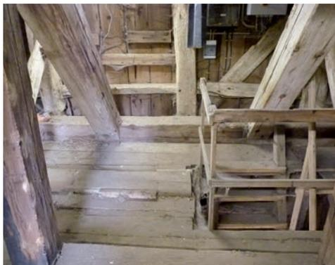
**Die Decke des Obergeschosses (Glockenboden) mit teilweise abgängigen Dielenbohlen**
