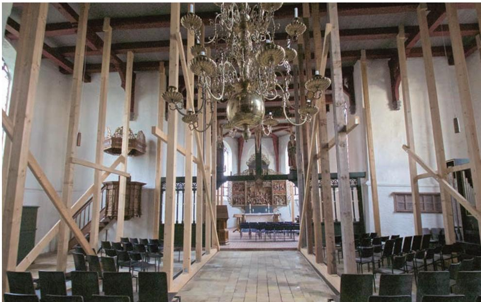
**Das Betreten der Kotzenbüller Kirche Sankt Nikolai ist nur dank einer provisorischen Stützbalkenkonstruktion sicher möglich**
