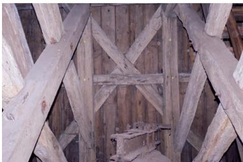
**Die in weiten Teilen intakte Tragkonstruktion aus 4 Eck- und jeweils 1 bzw. 2 Wand-Mittelständern mit waagerechten Riegeln, Doppelstreben und umlaufendem Rähm**
