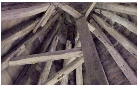
**Blick in die Dachspitze: Teilweise bereits ergänzte und teils geschädigte Dachsparren.**
