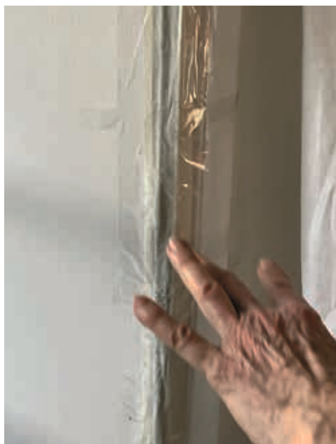
Dicke Risse über und neben den Fenstern. Entstanden durch absacken des Gebäudes
