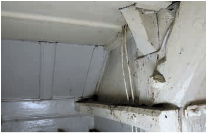
Abb. 6 Tragkonstruktion eines uthlandfriesischen Bauernhauses in Nordfriesland, um 1675: Ständer, angeblattetes Kopfband der Queraussteifung, diamantierte Knappe in der Längsaussteifung, Einzug zur Verbindung des Ständers mit dem Rähm der Außenwand.
