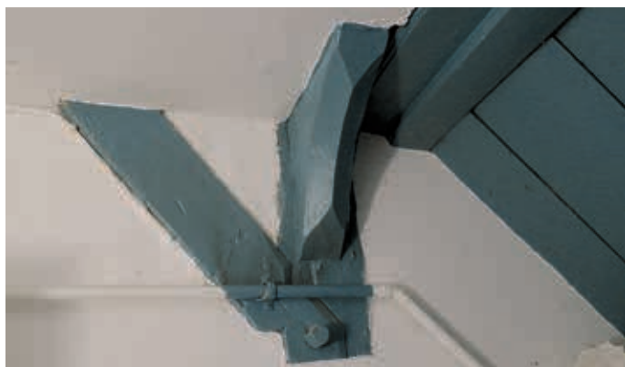
Abb. 4 und 5 Tragkonstruktion eines uthlandfriesischen Bauernhauses in Nordfriesland, um 1675: Ständer, angeblattete Kopfbänder in der Queraussteifung, diamantierte Knaggen in der Längsaussteifung.
