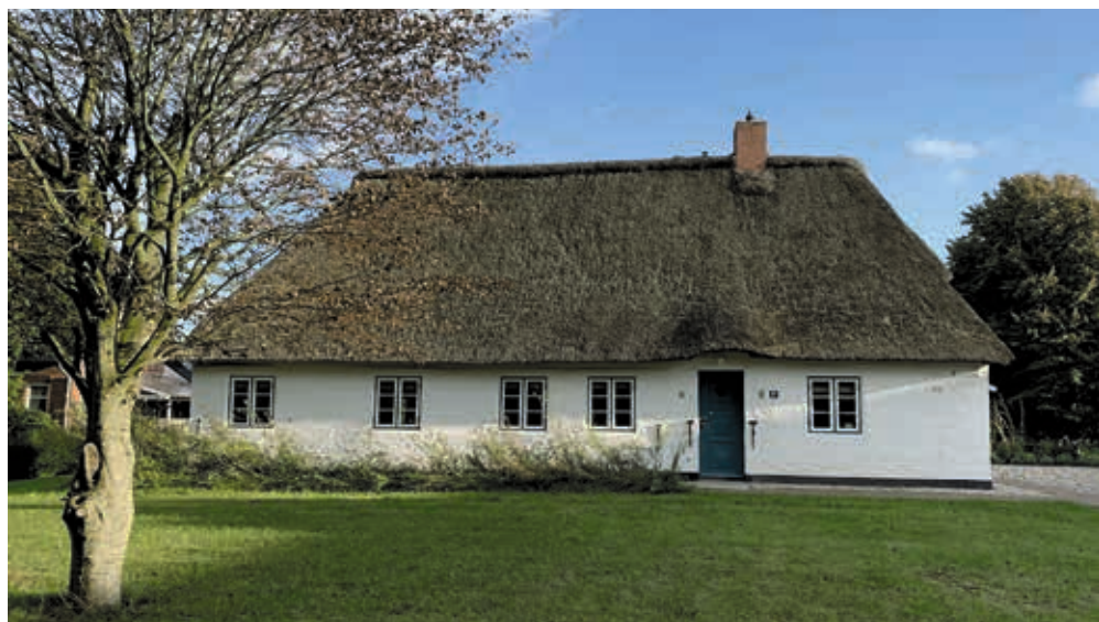
Abb. 11 – Ansicht von der Straße nach Sanierung
