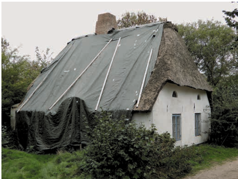
Das denkmalgeschützte Haus Twesk Diker 1 in Keitum auf Sylt
