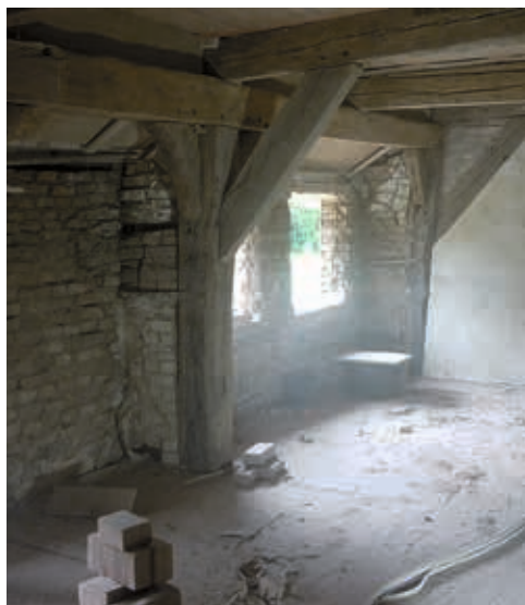
Abb. 5 – Trockeneisreinigung
