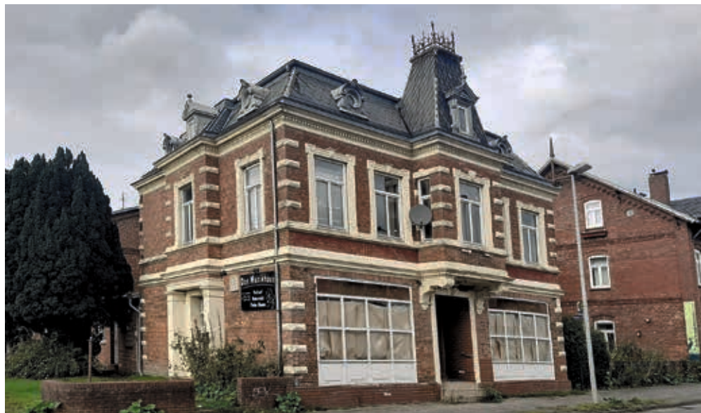
Der gründerzeitliche Gebäudekomplex in der Deezbüllers Straße
