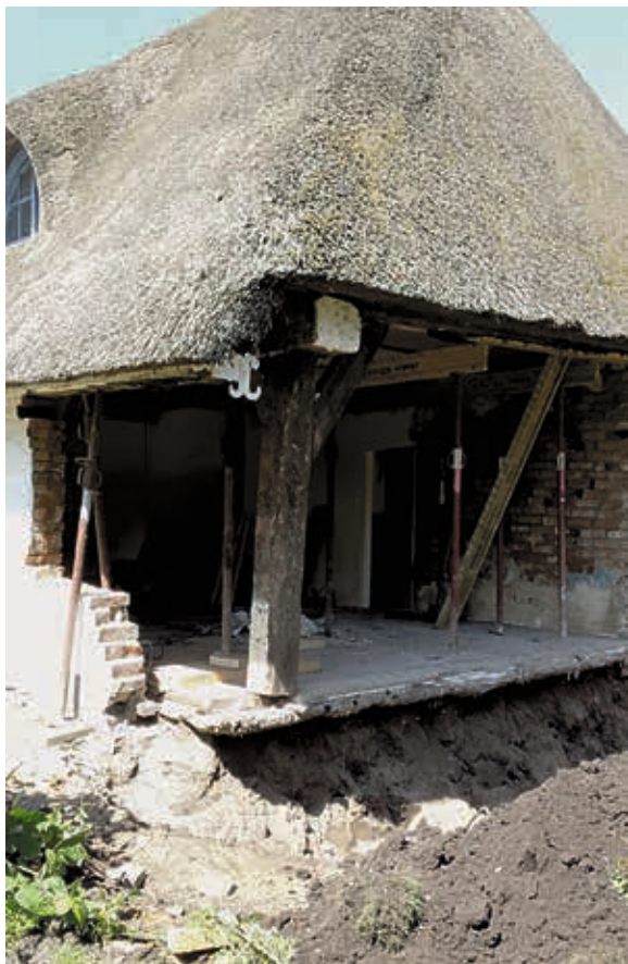
Abb. 15 – Ostseite nach Abbruch
