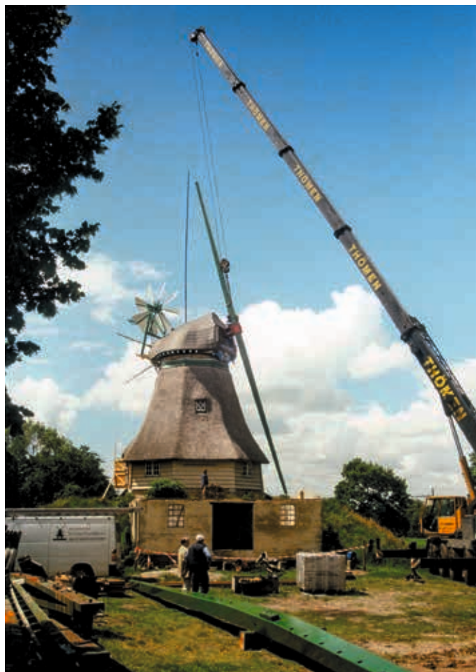
Abb. 3 Die aufwendige Sanierung der Mühle „Edda“ in Hopen wurde durch den Landesmühlenverband unterstützt und begleitet. 1999 erfolgte zum vorläufigen Abschluss der Arbeiten die Montage der Stahlruten. Gegenwärtig ist auch die Sanierung des Inneren in Vorbereitung.
