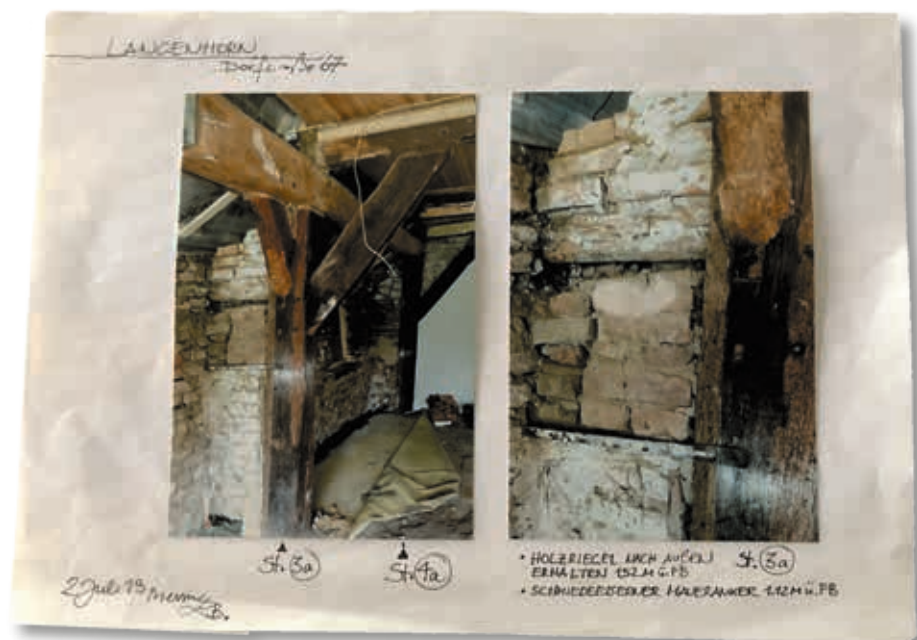
Abb. 16 – original erhaltene Innenständer Südseite 3a + 4a
