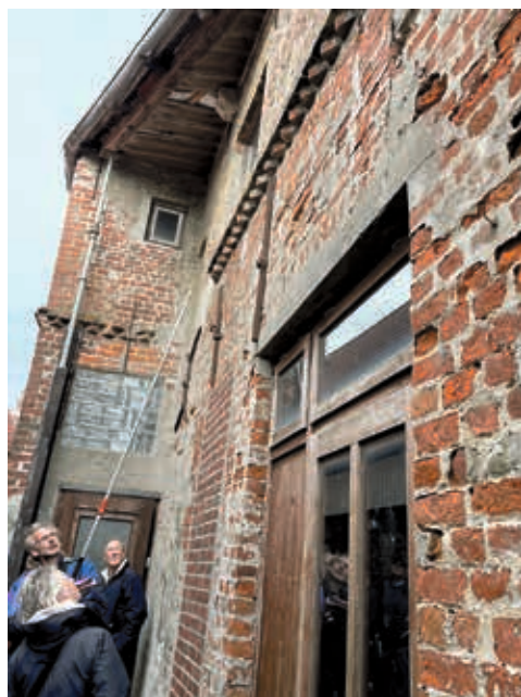
Johannes Matthießen erläutert Details des Ziegelmauerwerks.
