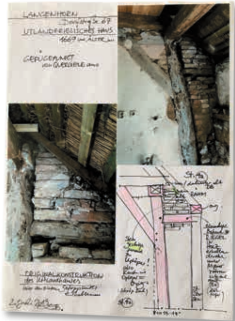
Abb. 17 – Innenständer 4a mit original Riegel nach außen (Querdiele) Foto Ellen Bauer
