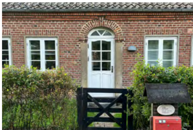
Abb. 32 Gendarmenhaus Nørremølle – Hauseingang mit gemauertem Rundbogen auf Betonpfeiler – heute.
