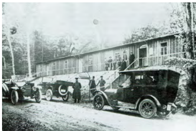
Abb. 6 Baracken für die Zollabfertigung und Passkontrolle in Kupfermühle ab November 1920
