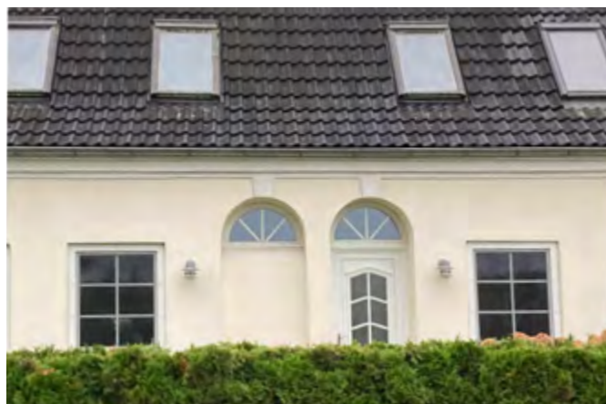
Abb. 51 Doppelhaus in Pluskjær, umgebaut zu einem Einfamilienhaus
