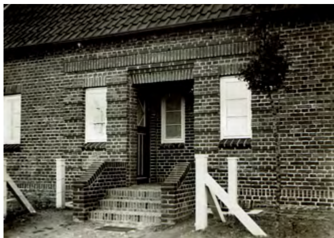
Abb. 29 Zollhaus Meierwik – Eingang mit rustizierten Lisenen gefasst (1923)
