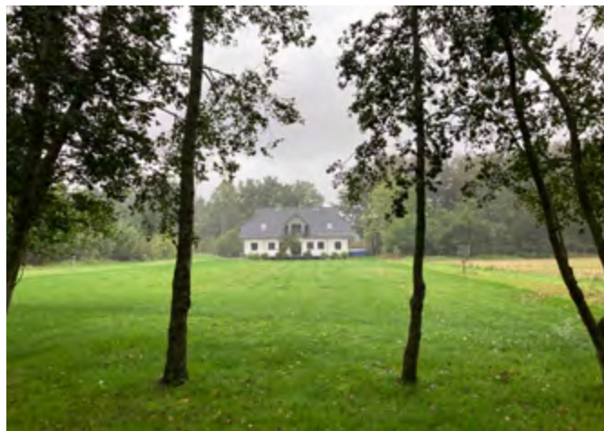
Abb. 52 Durchgreifend saniertes und zum Einfamilienhaus umgebautes ehemaliges Gendarmenhaus in Frøslevsfeld
