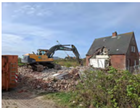
Abb. 58 Abriss des Zollhauses in Dagebüll im April 2024 Fig. 58 Nedrivning af toldhus i Dagebüll april 2024.
