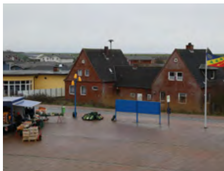
Abb. 57 Altes Zollhaus in Dagebüll, erbaut 1924 Fig.57 Gammelt toldhus i Dagebüll, bygget i 1924
